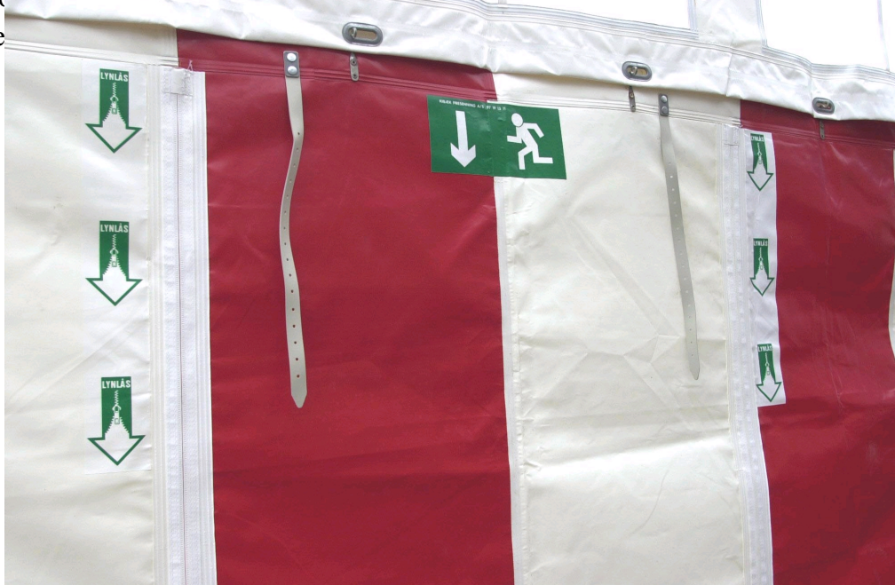
Figur 4 Eksempel på afmærkning af udgang forsynet med lynlåse.
